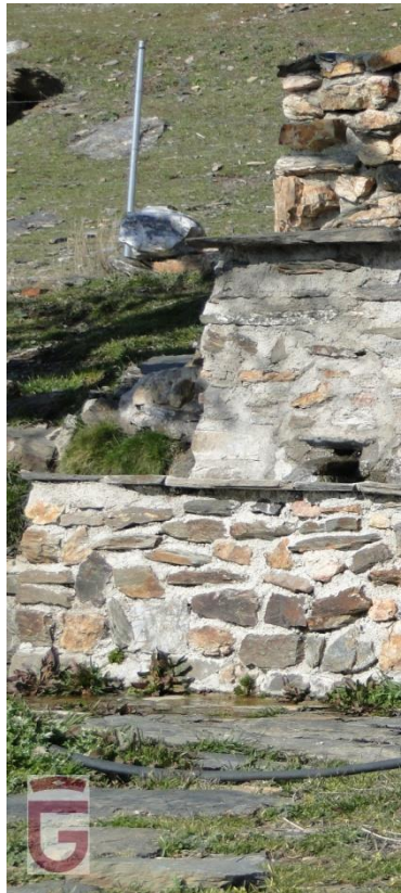
Fuente de las Herrerías (punto 4)
