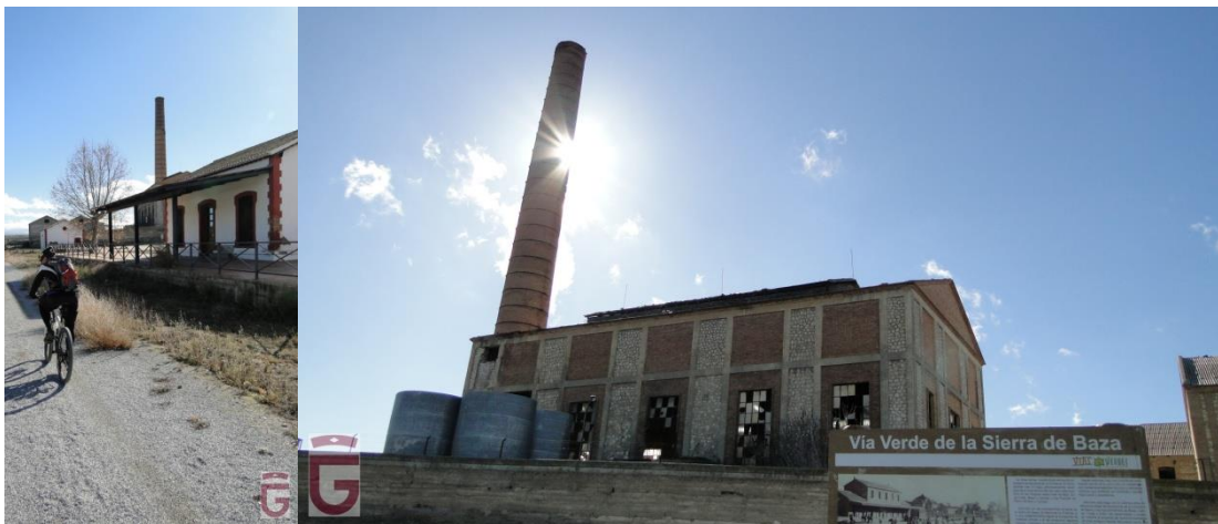
Estación y azucarera de Caniles (punto 11)
