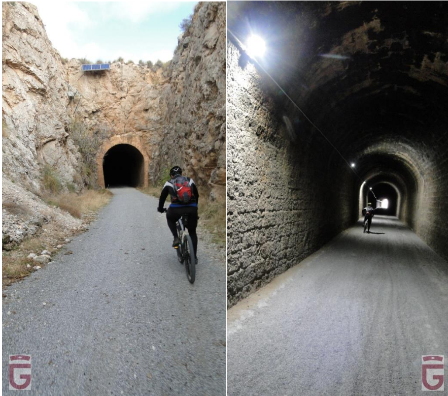
Túnel de Freila (punto 2)
