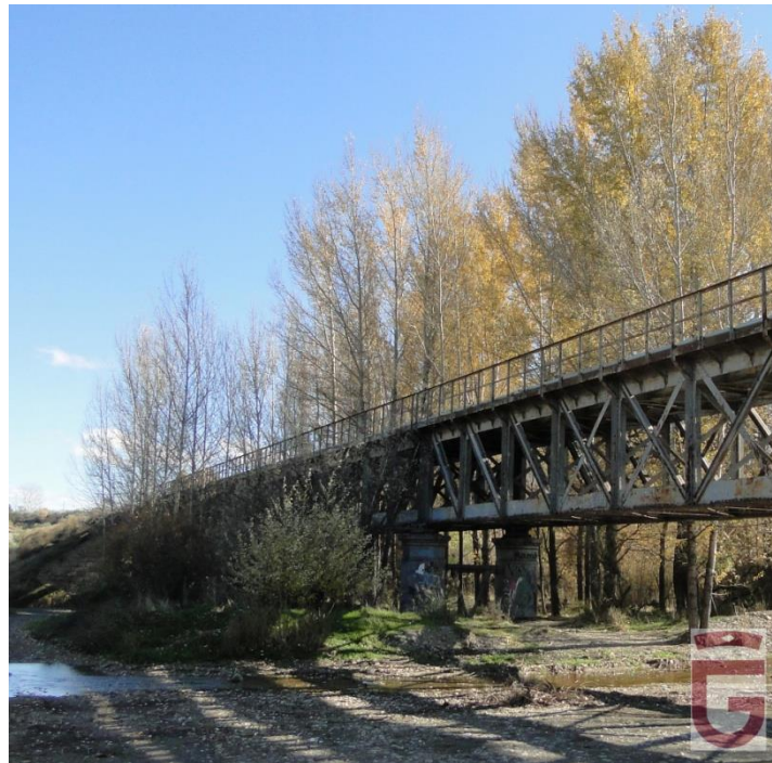
Puente de hierro de Caniles sobre el río Baza (punto 12)
